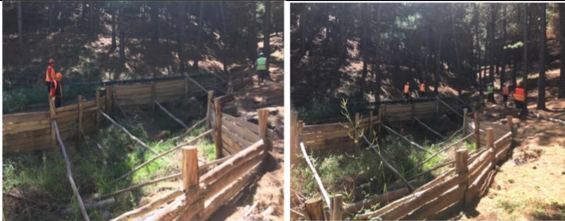
Obras de contención de erosión
